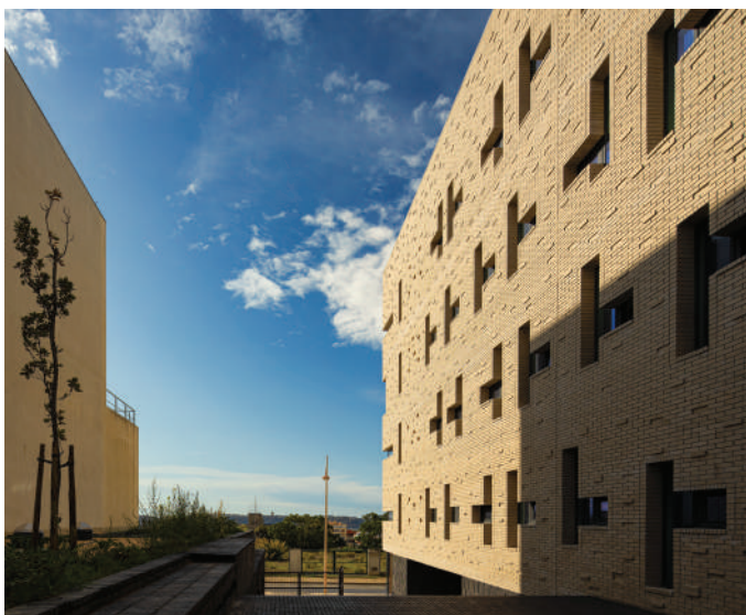
Residência do Polo da Ajuda © CVDB Arquitectos
