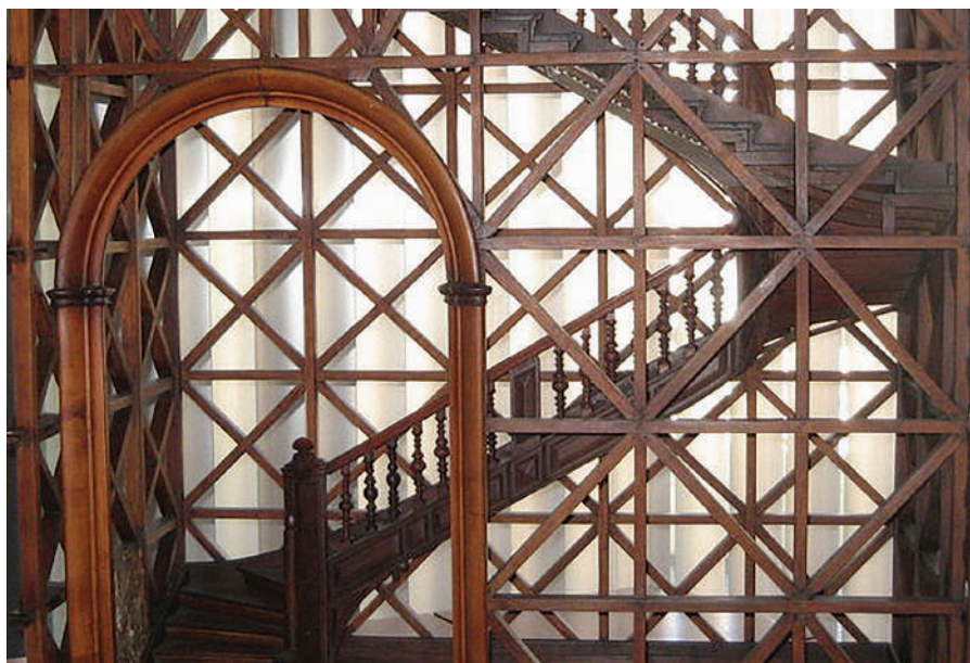
Maquete de gaiola pombalina © Museu de Engenharia Civil do Instituto Superior Técnico
