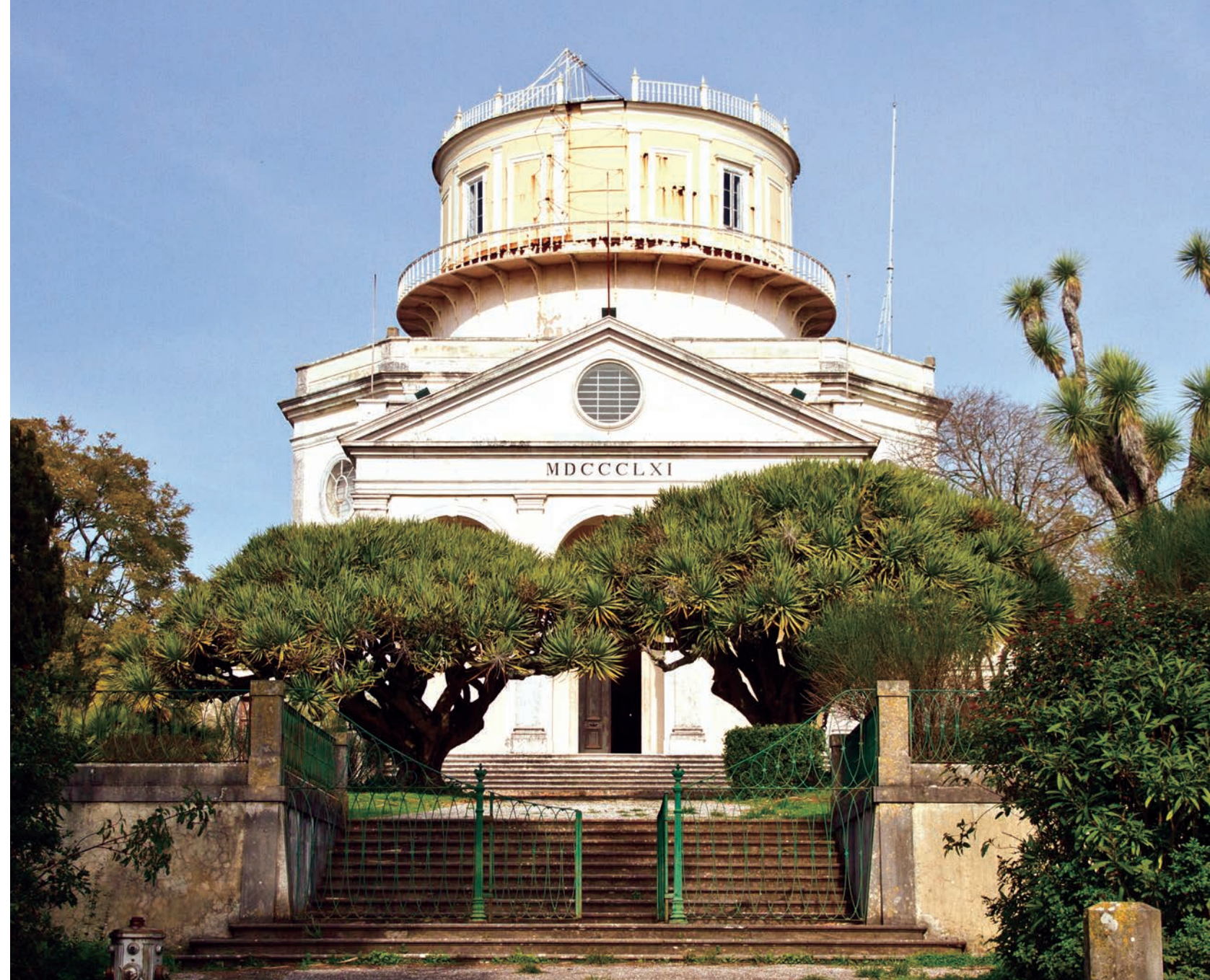
Fachada principal do edifício central, orientada a Sul © Duarte Pinheiro
